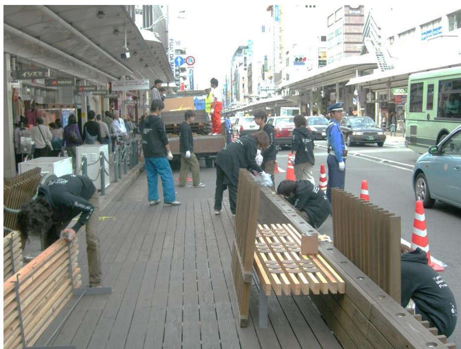
図 3-8 デッキ設置箇所及び設置状況
