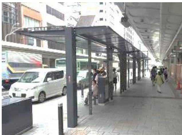
図 7-8 整備完了後のバス停の様子
